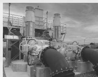
排水機場向け 耐水モータ 一体型ポンプ
